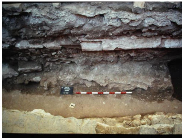
Vista des de l'oest del fonament del contrafort, UE 1186, de l'església del convent de Santa Caterina.
