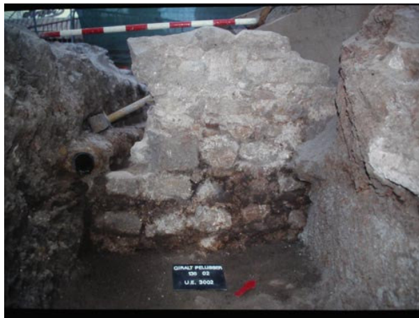
Vista des del sud de la fonamentació UE 3002.
