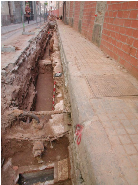
Vista des del nord de la fonamentació UE 1049.
